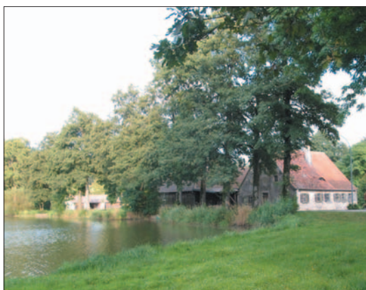
Teichmühle in Asbach
