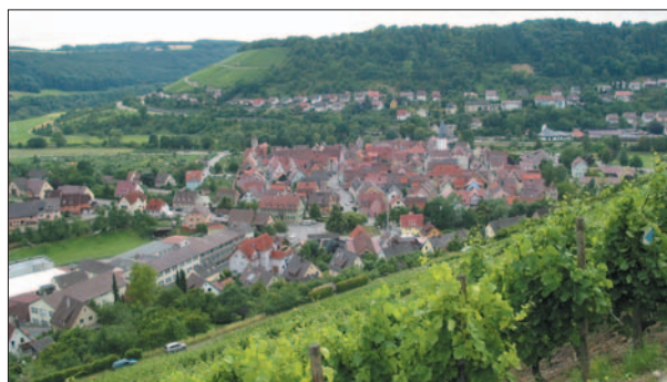
Gesamtanlage: Niedernhall (KÜN)
