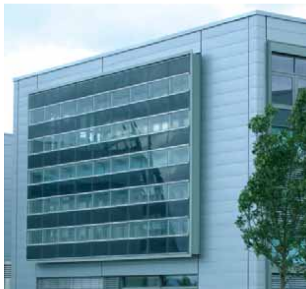
Abbildung 16: Solarenergienutzung auf Dächern und an Fassaden - hier in Schwäbisch Hall - hat Vorfahrt vor Freiflächenanlagen
