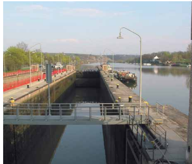
Abbildung 13: Den Neckar als Binnenschiffahrtsstraße gilt es langfristig zu sichern, hier die Schleuse in Lauffen a.N.
