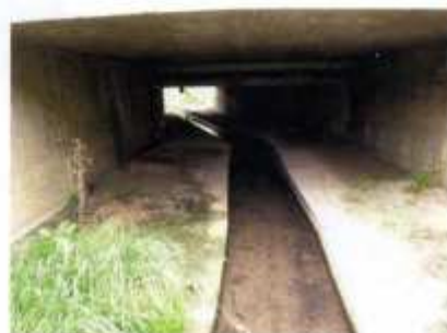
Abb. 34: M/K_W-1: Geeignete Unterführung für den Umbau zur Krepssperre im Schwabbach (Ortslage Schwabbach). (30.10.2015)
